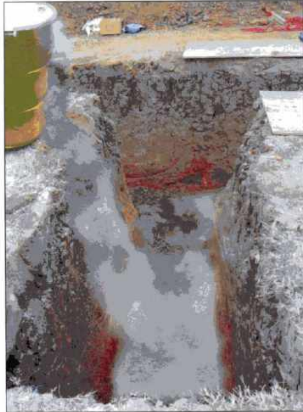
Imagen 24.23. Los vapores y gases más pesados que el aire pueden concentrarse en áreas bajas como zanjas, alcantarillas, manholes y otros espacios confinados.
