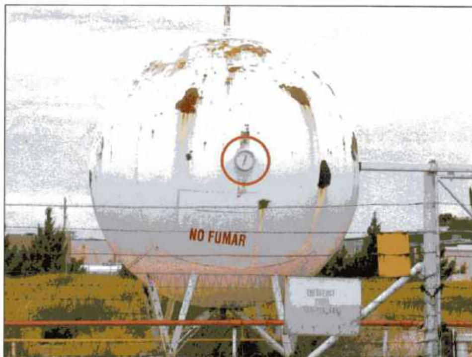
Imagen 24.100 El personal puede esperar que un contenedor presurizado tenga un manómetro. Cortesía de Rich Mahaney.
