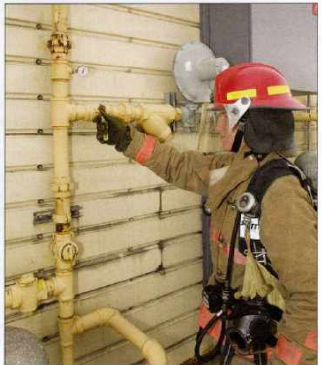
Imagen 26.66 Los respondedores pueden cerrar las válvulas de las líneas de gas natural residencial.
