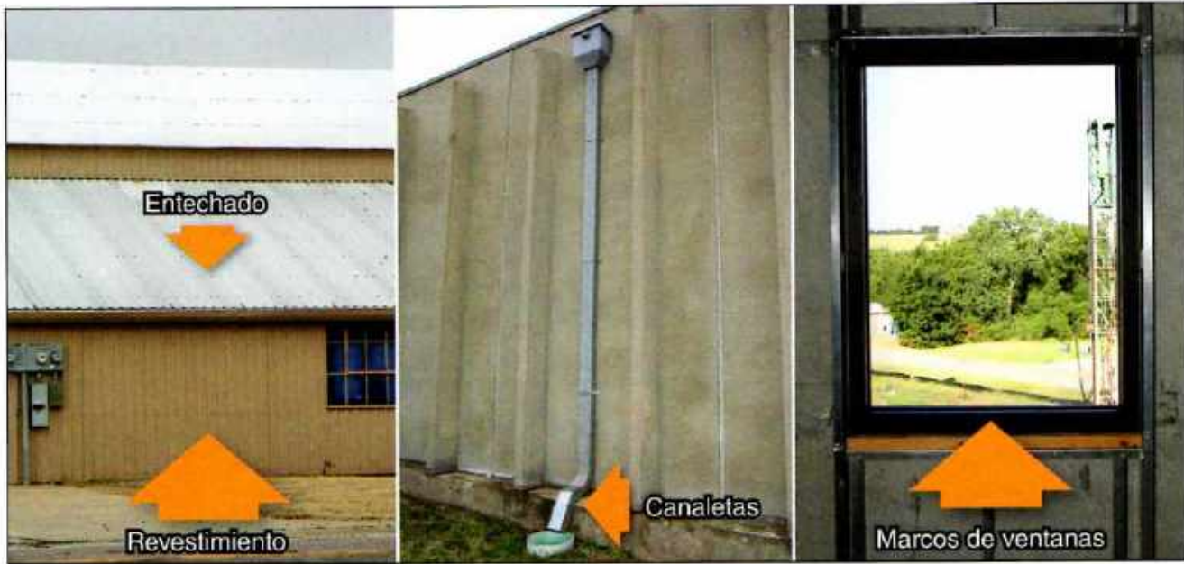
Imagen 16.8 Ejemplos de uso de aluminio para varios componentes de construcción.
