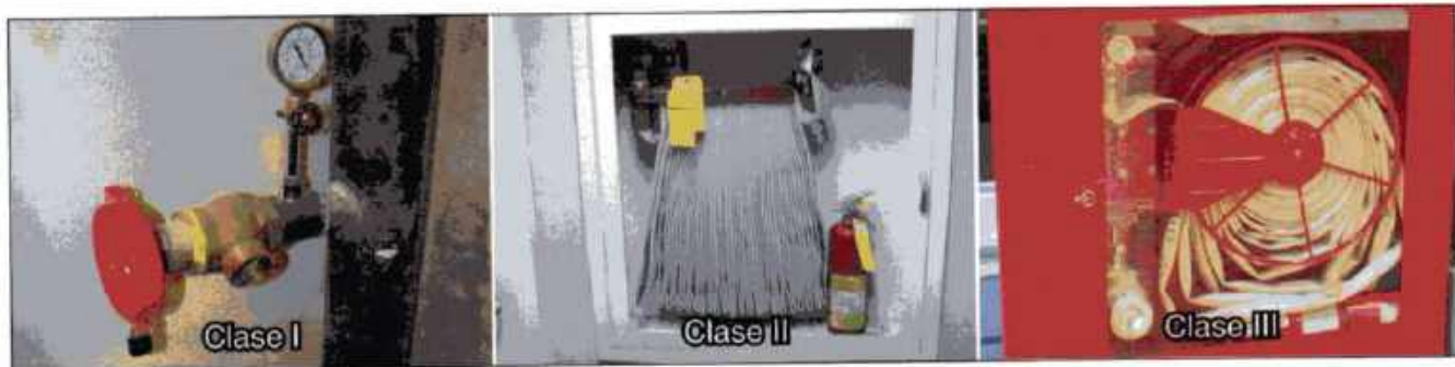
Imagen 22.29 Ejemplos de las tres clases de sistema de montantes.
