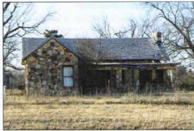
Imagen 16.17 Una edificación abandonada en estado de deterioro.
