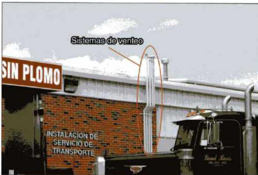
Imagen 24.132 Las unidades de almacenamiento subterráneo suelen contener líquidos como gasolina.
