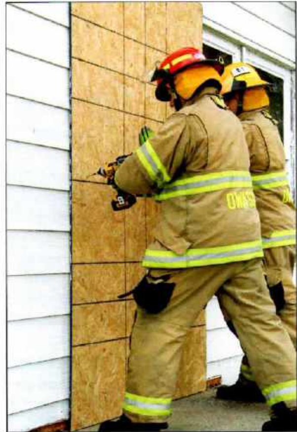
Imagen 15.32 Bomberos cubren una abertura con tableros de fibra orientada (OSB) para asegurar la escena.
