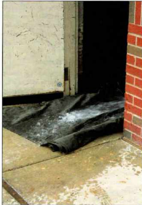
Imagen 15.22 Las canaletas de agua son útiles para canalizar la escorrentía de una edificación.
