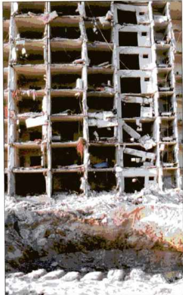
Imagen 25.52 Los coches y camiones bomba pueden causar mayores daños que las explosiones accidentales de gas. Los indicadores incluyen el concreto destrozado y el acero estructural doblado. Cortesía de la Fuerza Aérea de los Estados Unidos, foto del aviador senior Sean Worrell.
