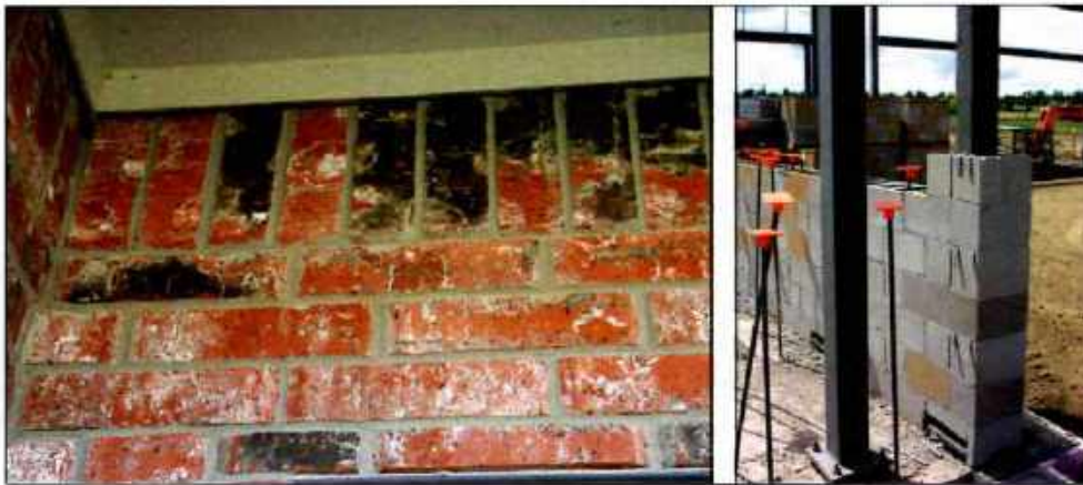
Imagen 16.2 Los ladrillos (izquierda) y los bloques (derecha) son materiales comunes de mampostería.
