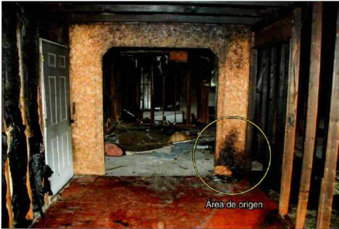
Imagen 15.28 El círculo en esta foto muestra el área de origen del fuego dentro de esta estructura. Cortesía de Donny Howard.
