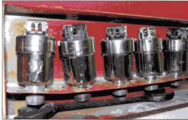
Imagen 22.24 Un gabinete de almacenamiento de rociadores contiene varios rociadores y una llave para los mismos.
