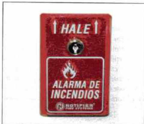
Imagen 22.16 Ejemplo de una estación de alarma manual que suele encontrarse en edificaciones públicas y comerciales.
