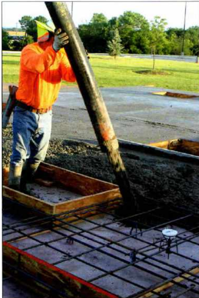
Imagen 16.9 Vertido de concreto alrededor de la varilla de refuerzo para formar concreto reforzado en una construcción.
