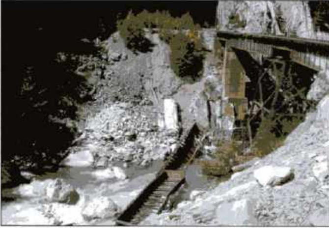
Imagen 24.74 Las ubicaciones que generalmente experimentan más accidentes de transporte, como puentes y caballetes ferroviarios, también tienen más probabilidades de estar involucradas en incidentes con materiales peligrosos. Cortesía de Phil Linder.
