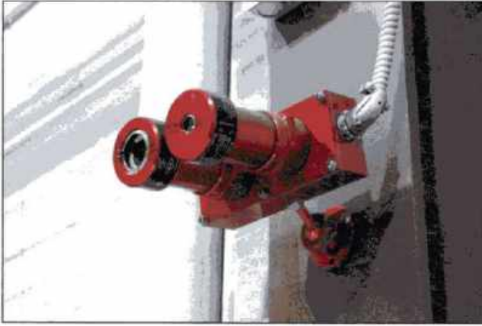
Imagen 22.19 Ejemplo de un detector de llamas encontrado en algunos hangares de aeronaves.
