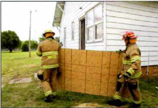
Paso 2: Reúna las herramientas, equipos y materiales.
