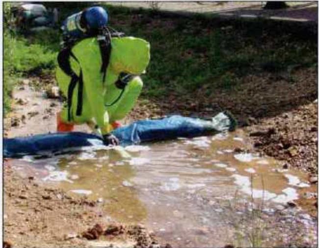
Imagen 26.41 Las represas pueden ser construidas para atrapar materiales que son más livianos o más pesados que el agua, dependiendo de su gravedad específica.
