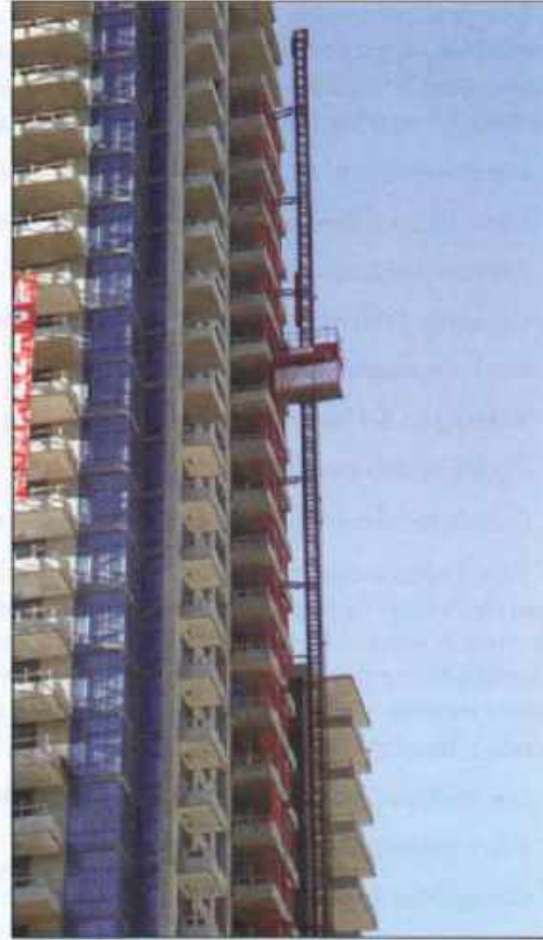
Imagen 17.12 Un ascensor de construcción en el costado de un edificio de gran altura que se está construyendo.
