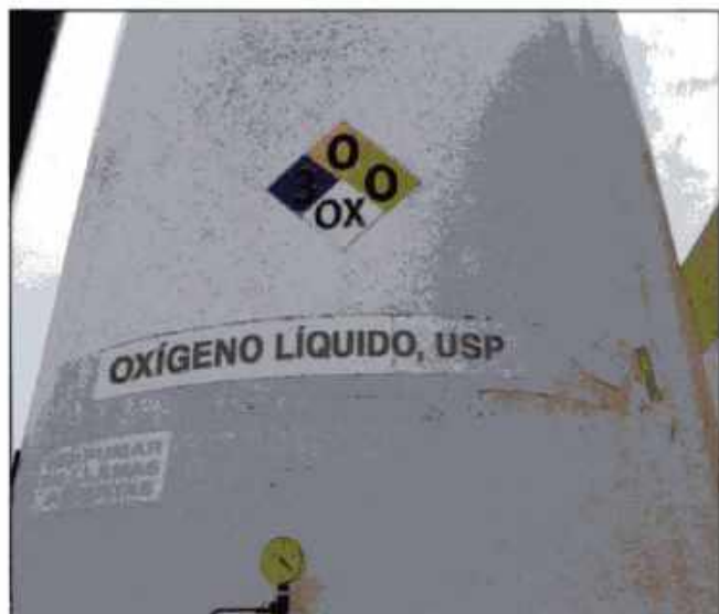
Imagen 24.34. El oxígeno líquido es un oxidante poderoso. Si se derrama en asfalto, muy poca energía de activación es necesaria para provocar una explosión.
