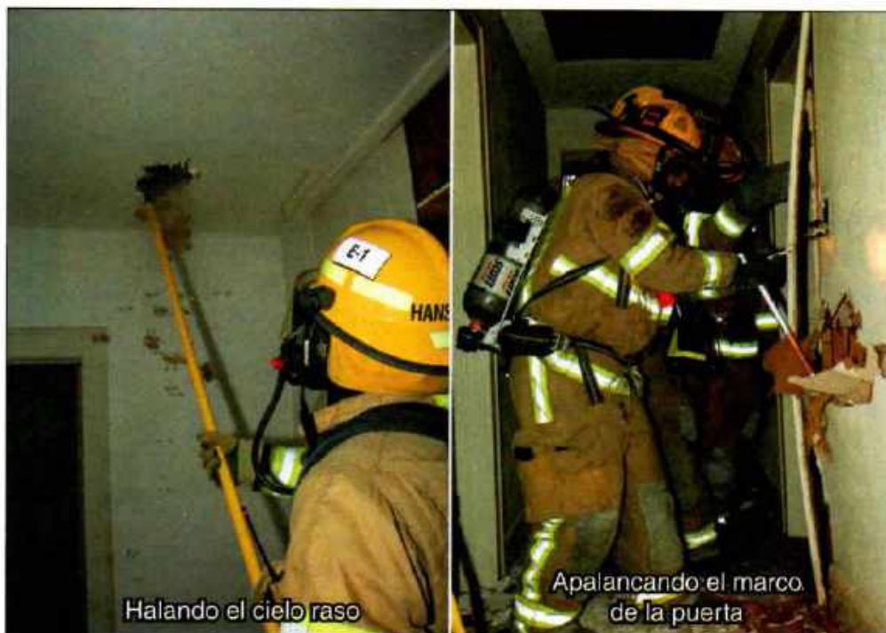
Imagen 15.2 Bomberos utilizando una pértiga (izquierda) y una herramienta Halligan (derecha) durante las operaciones de revisión posterior al incendio.
