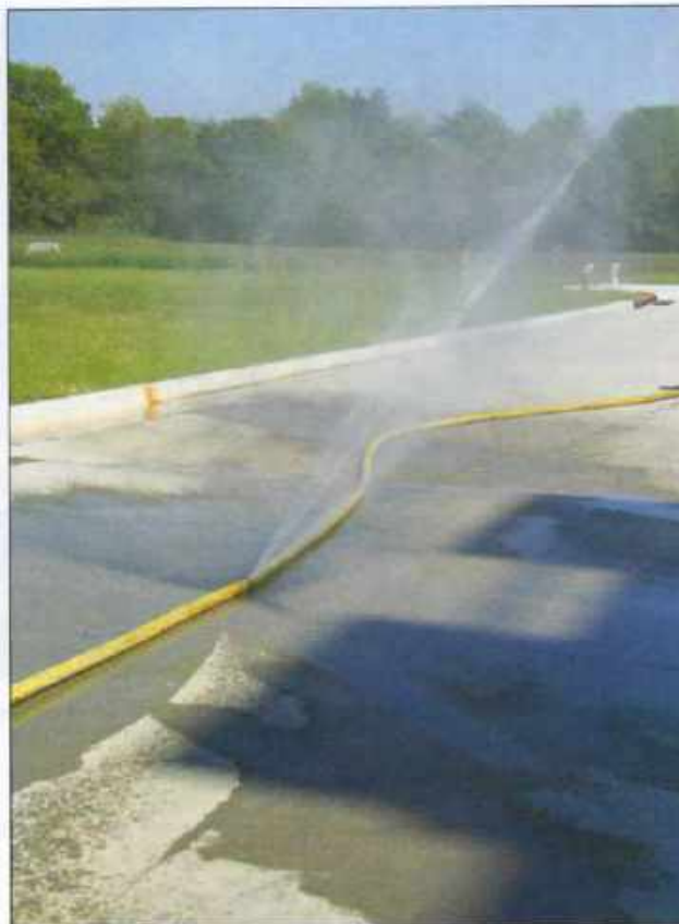
Imagen 21.6 Los tramos de manguera contra incendios fallan ocasionalmente en la prueba de manguera al romperse o reventarse.
