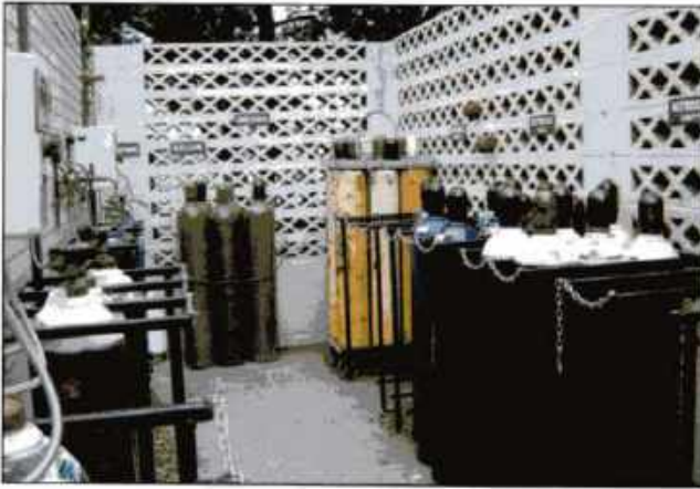
Imagen 24.93 Los cilindros de gases comprimidos fácilmente reconocibles pueden contener helio y nitrógeno bajo presión.
