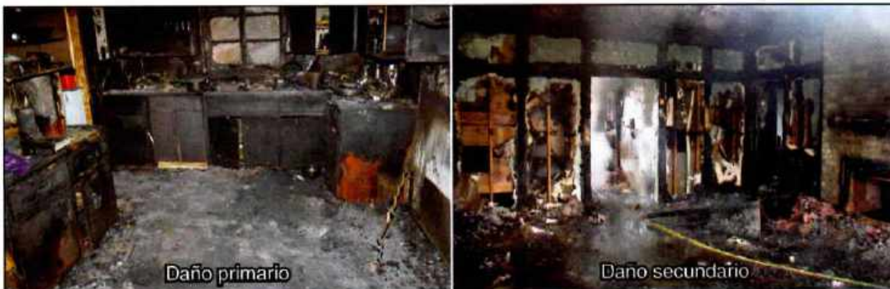
Imagen 15.1 Ejemplos de daños primarios y secundarios causados a dos estructuras debido al fuego, el humo y las actividades de extinción de incendios. La foto de los daños primarios es cortesía de Donny Howard, Yates y Asociados. La foto del daño secundario es cortesía de Ron Moore, McKinney (TX) FD.
