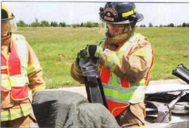
Imagen 17.39 Los bordes afilados se pueden cubrir con secciones cortas de manguera contra incendios o cinta adhesiva.
