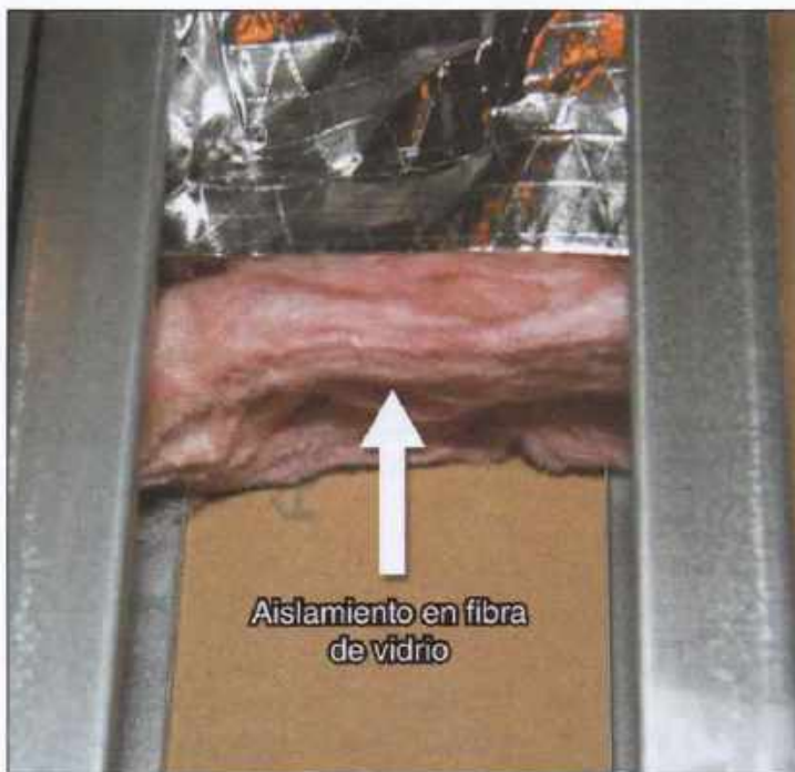
Imagen 16.13 Aislamiento de fibra de vidrio utilizado para insonorización en una pared interior.
