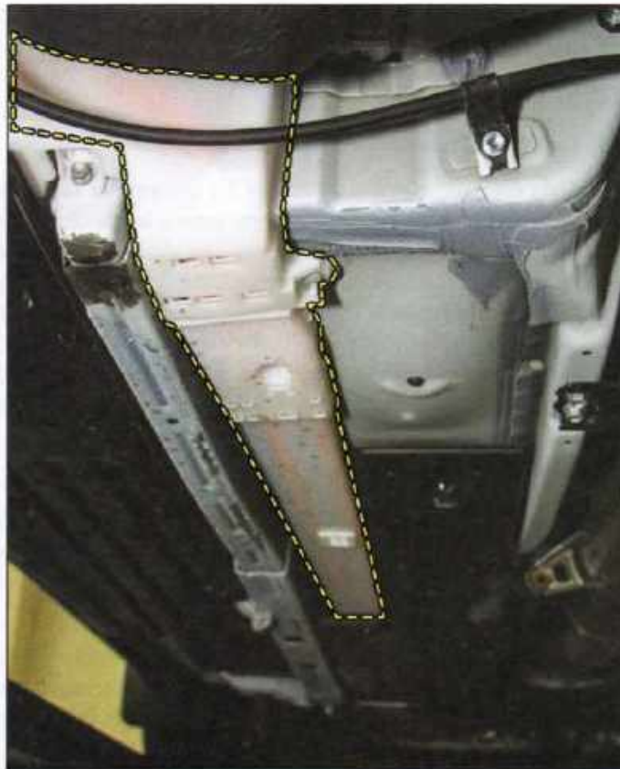
Imagen 17.43 Un cable de alimentación de alto voltaje pasa debajo de la cubierta de plástico blanca que se describe en esta foto.
