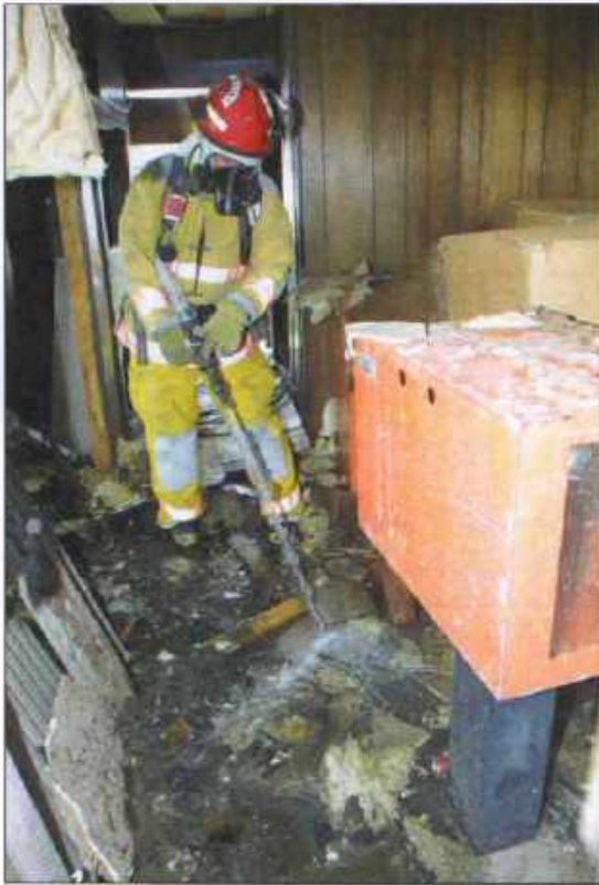
Imagen 20.1 Las operaciones de extinción, salvamento y revisión posterior al incendio pueden mover o destruir la evidencia del origen y la causa de un incendio.
