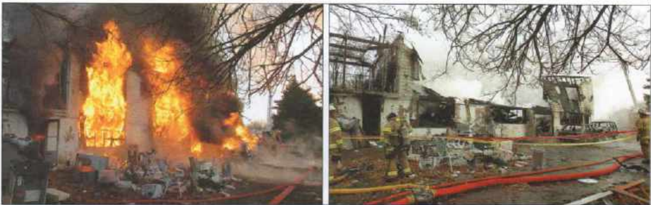
Imagen 16.16 Un incendio provocó la tala y el colapso estructural de esta casa. Fotos cortesía de Bob Esposito, Pennsburg, PA.
