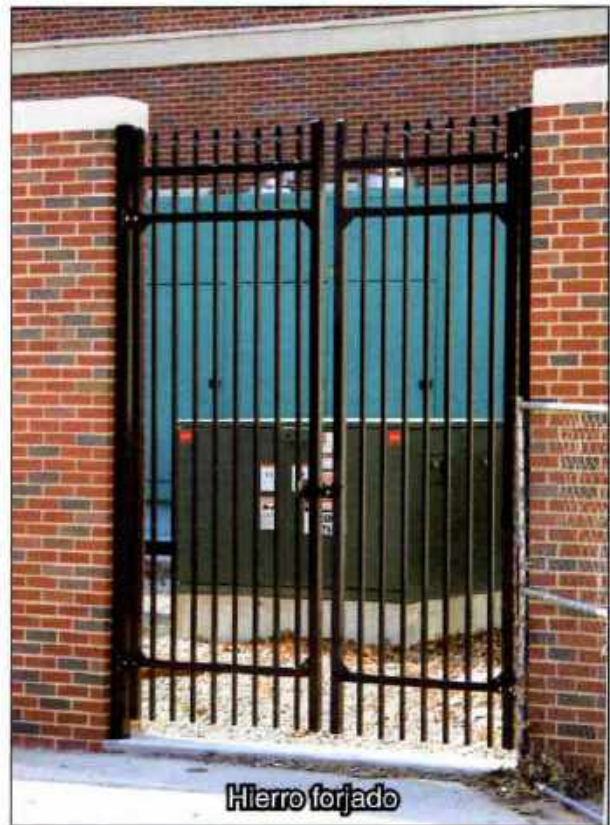
Imagen 16.5 Este portón de hierro forjado es funcional y decorativo.
