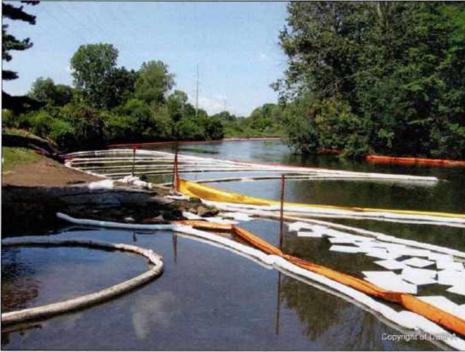
Imagen 26.35 Las grandes derrames pueden requerir de barreras de contención flotantes. Cortesía de la Agencia de Protección del Medio Ambiente de los Estados Unidos.
