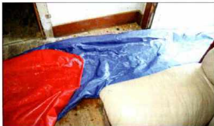
Imagen 15.24 Empalme de una canaleta con una trampa. Los bomberos pueden drenar el agua al exterior de la edificación.
