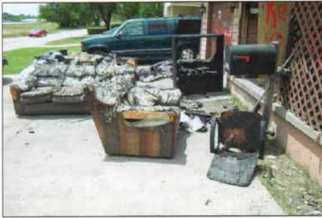
Imagen 20.22 Desechos carbonizados removidos de una estructura antes de asegurar la edificación. Cortesía de Yates and Associates.
