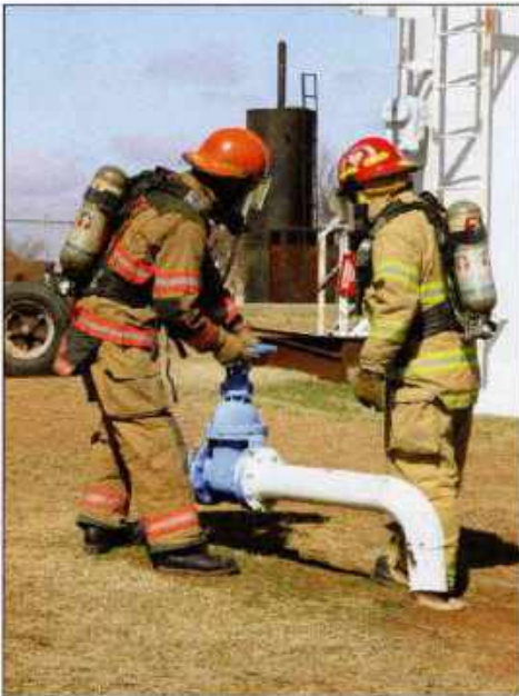
Imagen 26.64 Las válvulas remotas pueden cerrarse para detener el flujo de un material a través de tuberías o ductos.
