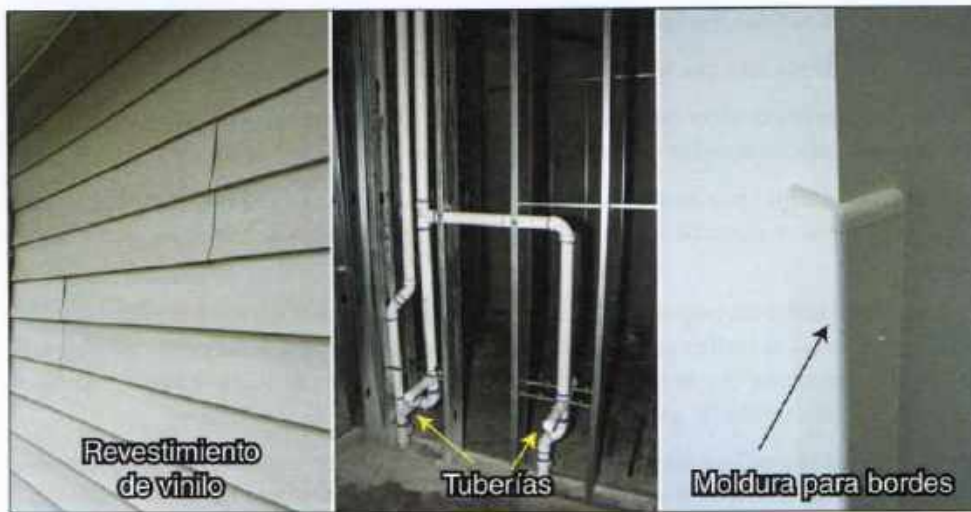
Imagen 16.14 Ejemplos de plásticos que se utilizan para diversos propósitos en la construcción.
