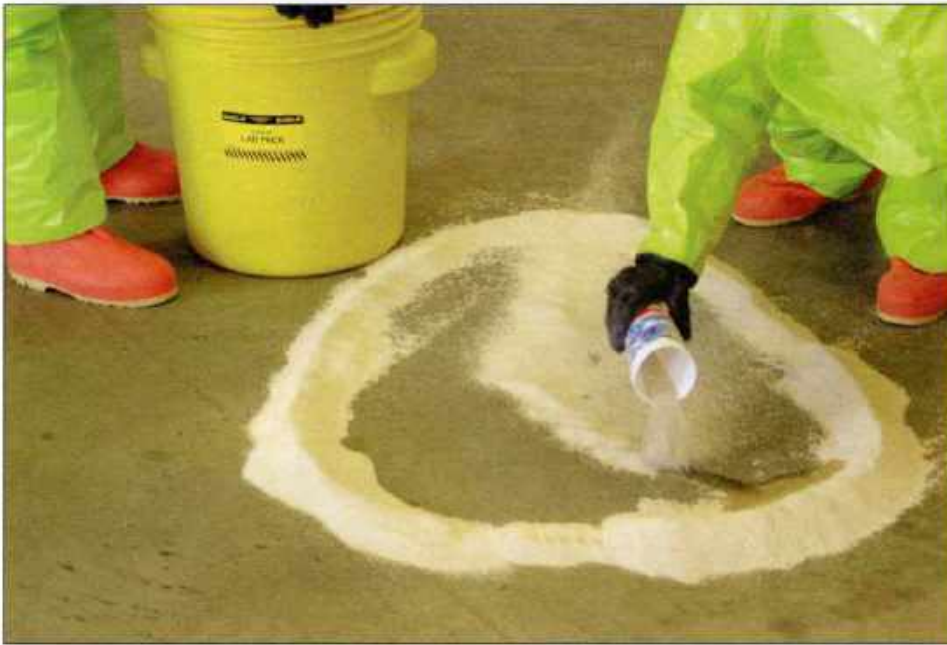
Imagen 26.36 Materiales absorbentes son usados para absorber/retener materiales peligrosos.
